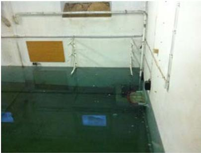
In der Winterpause hatten wir ein kleines Schwimmbad im Haus. Dank Herrn Roller, der die Wassermassen im großen Heizungskeller rechtzeitig bemerkte, konnte ein größerer Bauschaden rechtzeitig verhindert werden. An einem Rohr war ein Frostschaden aufgetreten, der nach dem Auftauen dem Wasser freien Lauf ließ. Nach Abstellen des Haupthahns legte die
